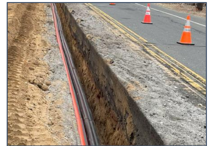
Conduit Installation
