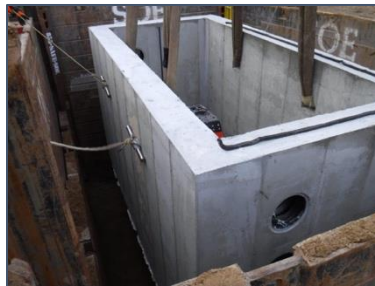
Instalación de bóveda
