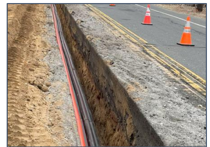
Instalación de conductos
